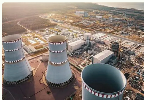
Figure ( 40 ) Centrale nucléaire d'El Dabaa
