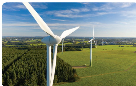
Figure ( 25 ) Les turbines éoliennes
