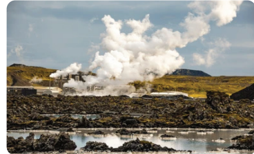
Figure ( 41 ) Centrale géothermique
